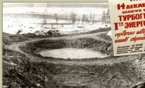
Подготовка котла под дымовую трубу НГРЭС, 1981 г.
