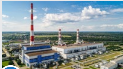
5 ТЭЦ-27 Мосэнерго 2 энергоблока по 450 МВт
