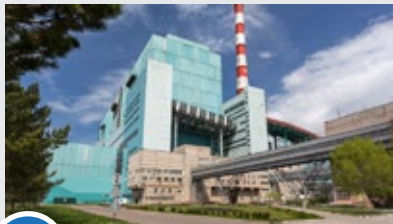
1 Березовская ГРЭС энергоблок 800 МВт
