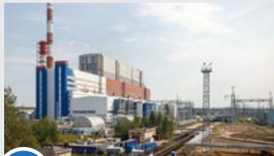
2 Пермская ГРЭС энергоблок 800 МВт
