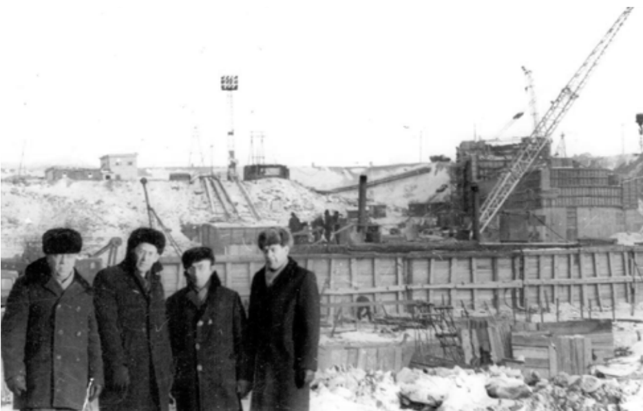
Рабочий визит на строительство Зейской ГЭС (слева направо: начальник строительства ГЭС, начальник диспетчерской службы ОДУ Востока Г. А. Сезионов, диспетчеры ОДУ Востока Н. И. Духовный и В. В. Смирнов), декабрь 1969 года
