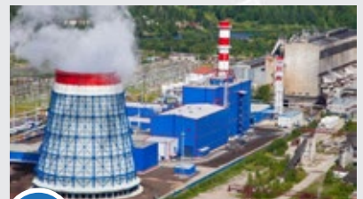
10 Яйвинская ГРЭС энергоблок 422,3 МВт
