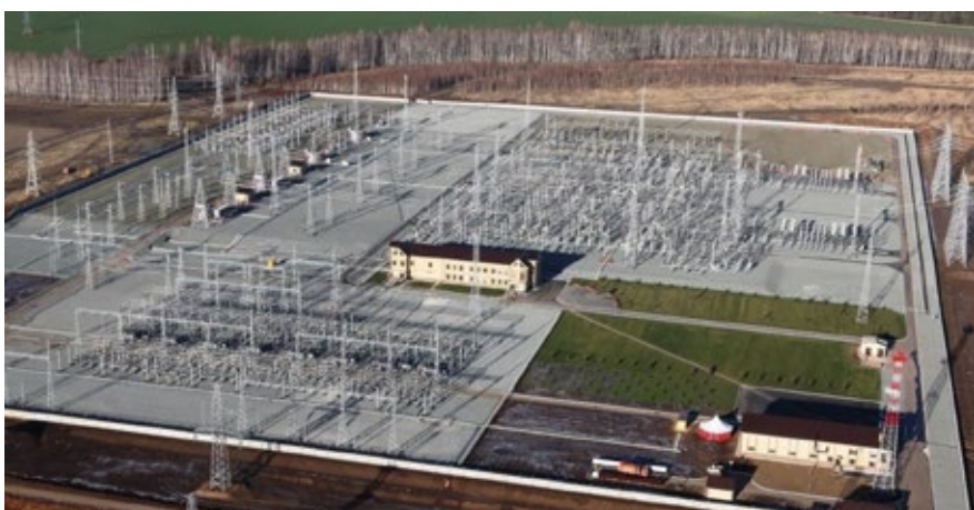
На ПС Щелоков впервые в стране реализован проект дистанционного управления оборудованием подстанции класса напряжения 500 кВ
