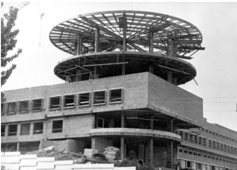
Строительство здания ОДУ Средней Волги, 1976 год
