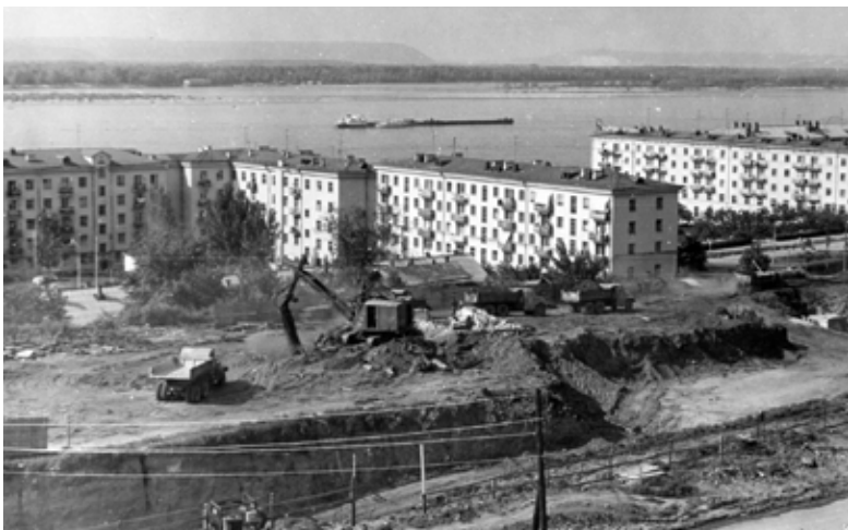
Начало строительства здания ОДУ Средней Волги, 1972 год
