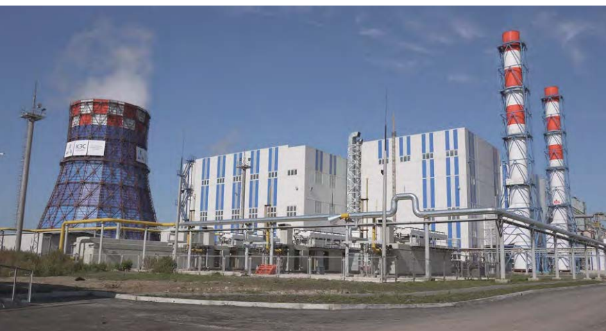
Сызранская ТЭЦ, ПГУ 225 МВт., 2012 год
