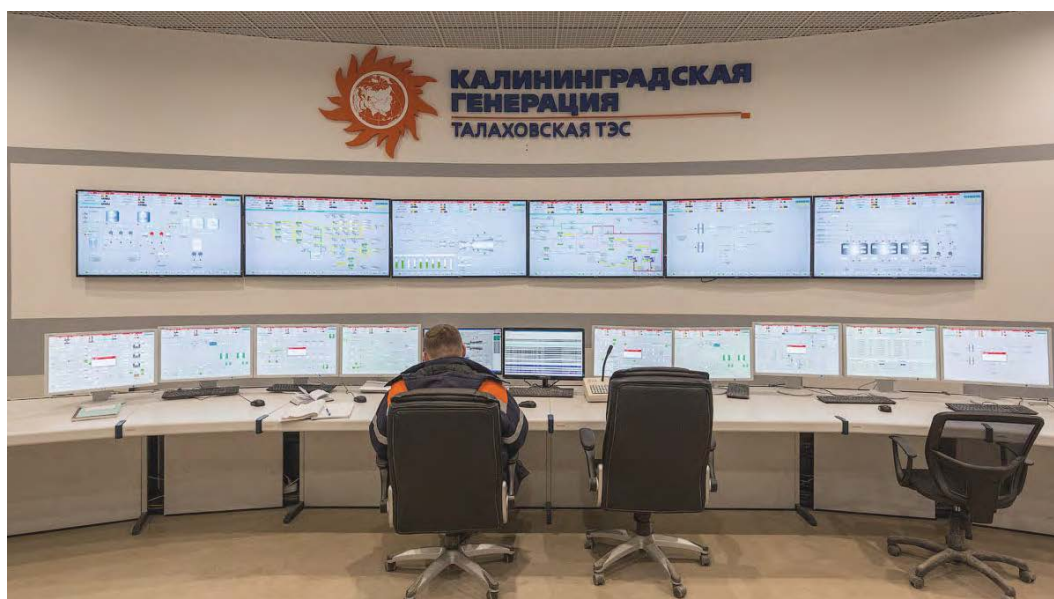
Блочный щит управления Талаховской ТЭС
