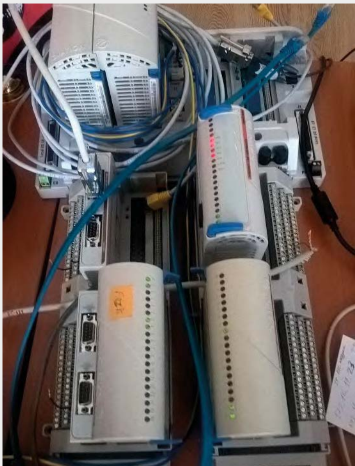
Имитатор ГРАМ во время полигонных испытаний в АО «СО ЕЭС»
