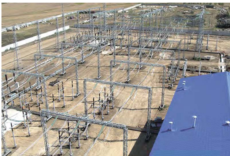
ПС 500 кВ Красноармейская
