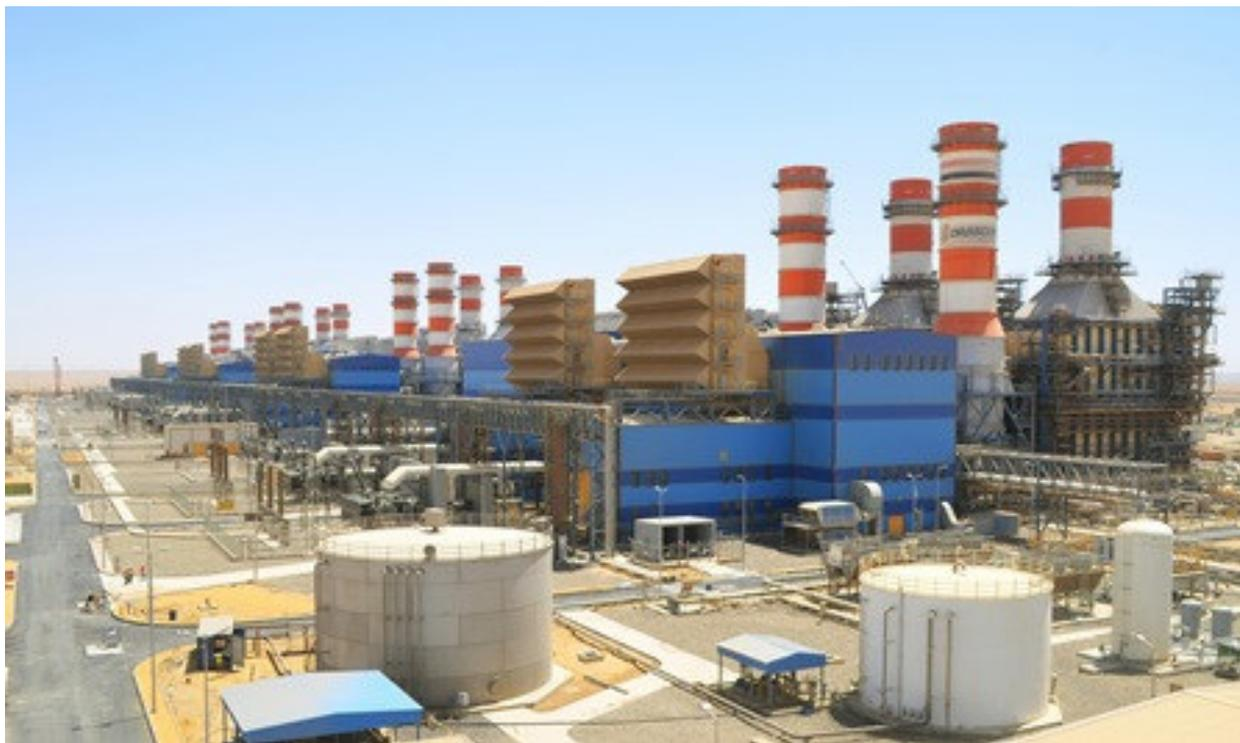
Контрактные обязательства Siemens предусматривают строительство станции на условиях «под ключ», включая изготовление, поставку и установку газовой турбины SGT5-4000F, паровой турбины SST5-3000, генератора SGen5-2000H, парогенератора с рекуперацией тепла и систему автоматического управления SPPA-T3000. Siemens также будет осуществлять эксплуатацию и обслуживание ПГЭС в течение 20 лет,
