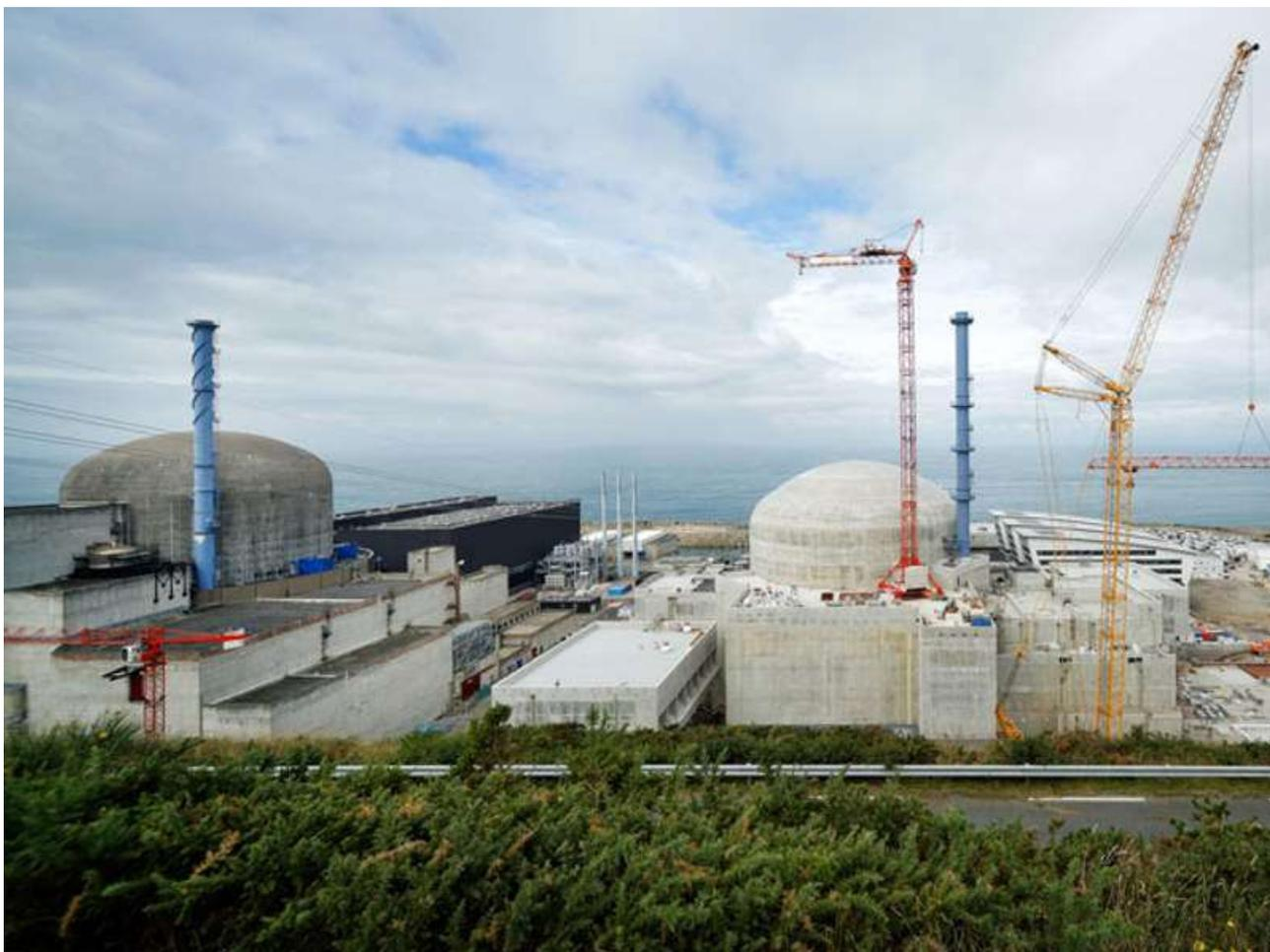
В состав энергоблока Фламанвиль-3 входит крупнейший в Европе ядерный EPR-реактор<sup>3</sup> с самой большой в мире паровой турбиной мощностью 1,75 ГВт. Тепловая мощность энергоблока составит 4,3 ГВт, годовая выработка электроэнергии – 13 ТВт\*ч.
