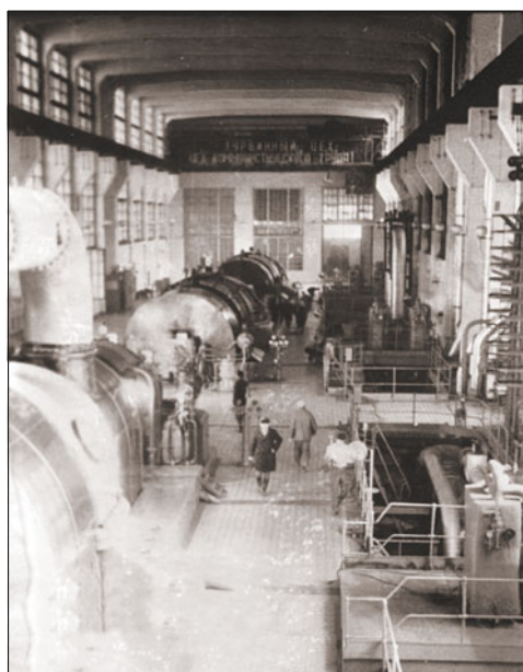
Машинный зал Каширской ГРЭС, 1941 г.
