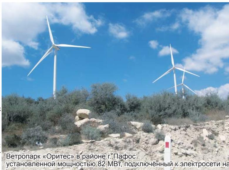
Ветропарк «Оритес» в районе г. Пафос установленной мощностью 82 МВт, подключённый к электросети напряжением 132 кВ
