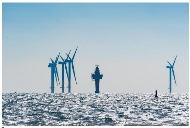
На площадке ВЭС установлены 84 ветровые турбины производства компании Siemens Gamesa мощностью 7 МВт каждая. Высота лопасти турбины в верхней точке составит 188 м над уровнем моря. Глубина моря в месте размещения станции достигает 58 м.
