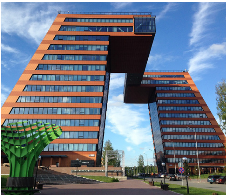
АО «СО ЕЭС» совместно с АО ГК «Тион» провели эксперимент по управлению спросом на электроэнергию путем снижения потребления системы вентиляции здания Центра коллективного пользования, расположенного в Новосибирском Академпарке
