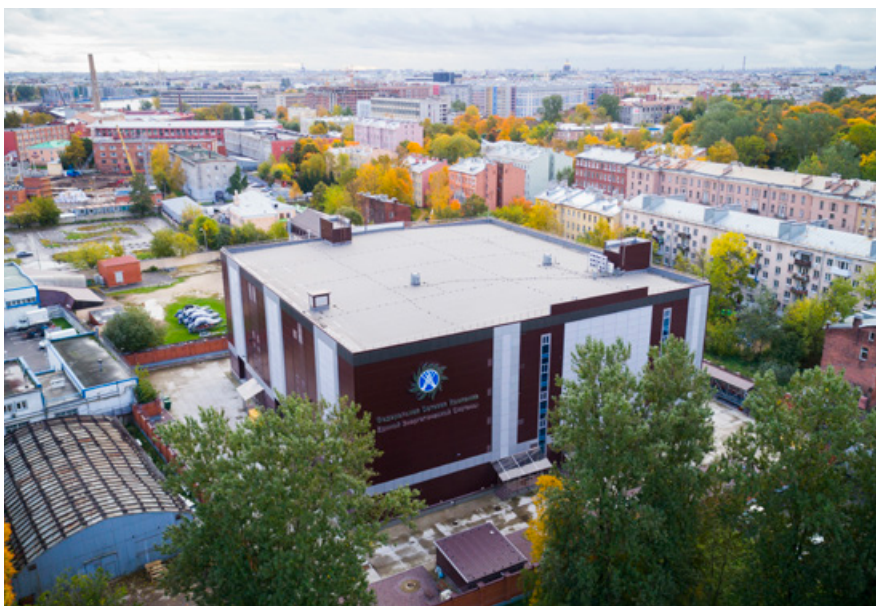
При управлении работой ПС 330 кВ Василеостровская специалисты ОДУ Северо-Запада и Ленинградского РДУ применяют автоматизированную систему производства переключений по выводу из работы и вводу в работу ЛЭП и оборудования с использованием телеуправления, которая была введена в промышленную эксплуатацию в 2018 году
