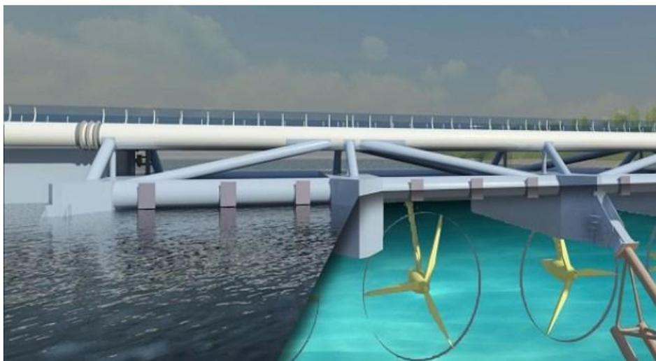
На первой стадии проекта на плотине длиной 800 м в проливе Ларантука между островами Флорес и Адонара будет размещена станция проектируемой мощностью от 18 до 23 МВт. Второй этап может предусмотреть увеличение установленной мощности станции до 90-115 МВт.
