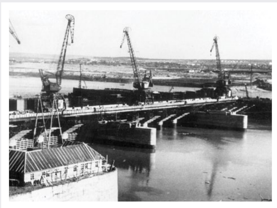
Строительство Камской ГЭС. Начало 1950-х годов
