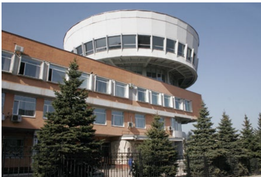
Здание ОДУ Средней Волги строилось при непосредственном участии Альбины Петровны
