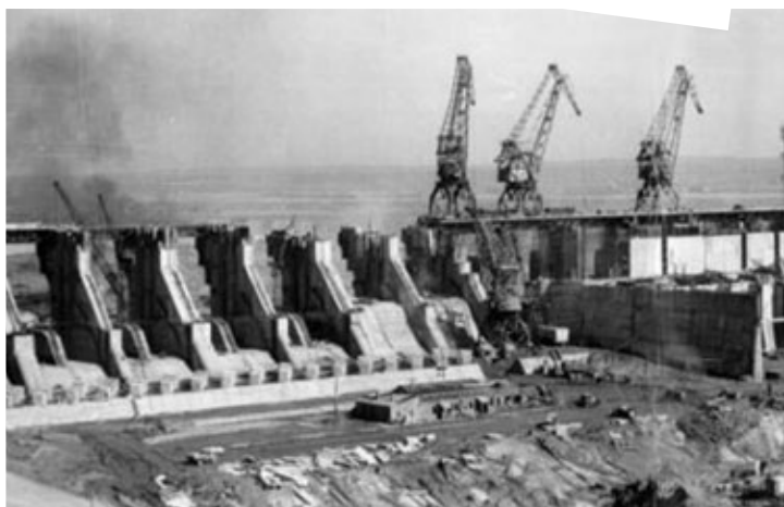
Строительство Воткинской ГЭС
