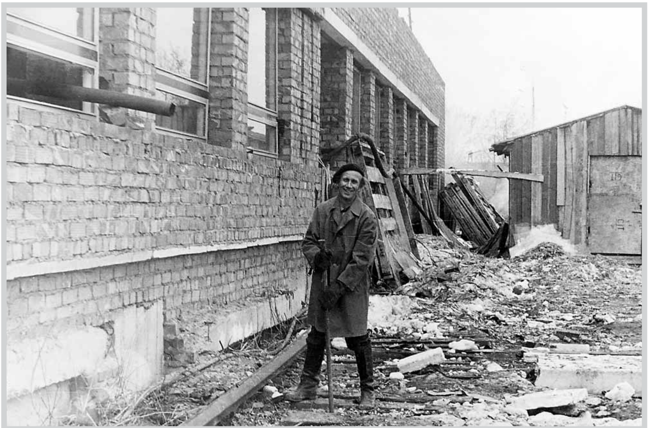
В.А. Сенаторов на субботнике по подготовке фронта работ для отделочников фасада
