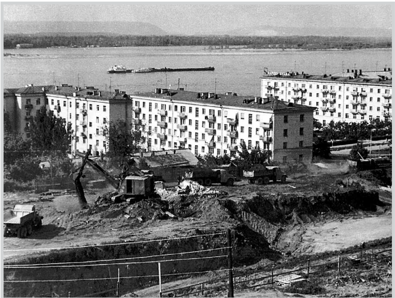
Котлован под здание ОДУ. 1972 год
