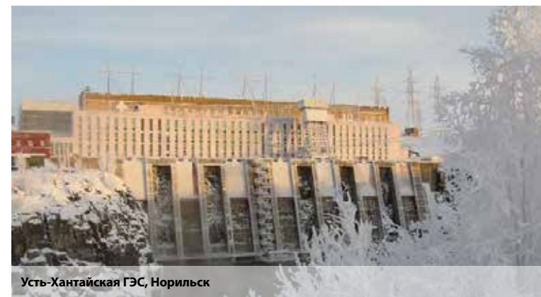
Усть-Хантайская ГЭС, Норильск
