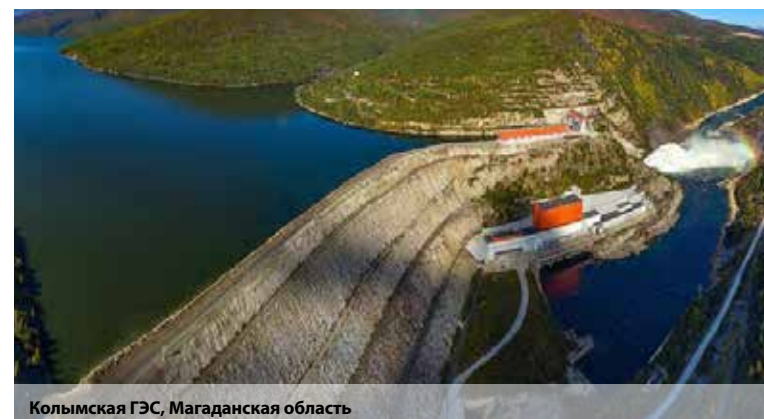
Кольимская ГЭС, Магаданская область
