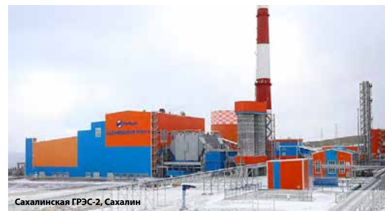
Сахалинская ГРЭС-2, Сахалин
