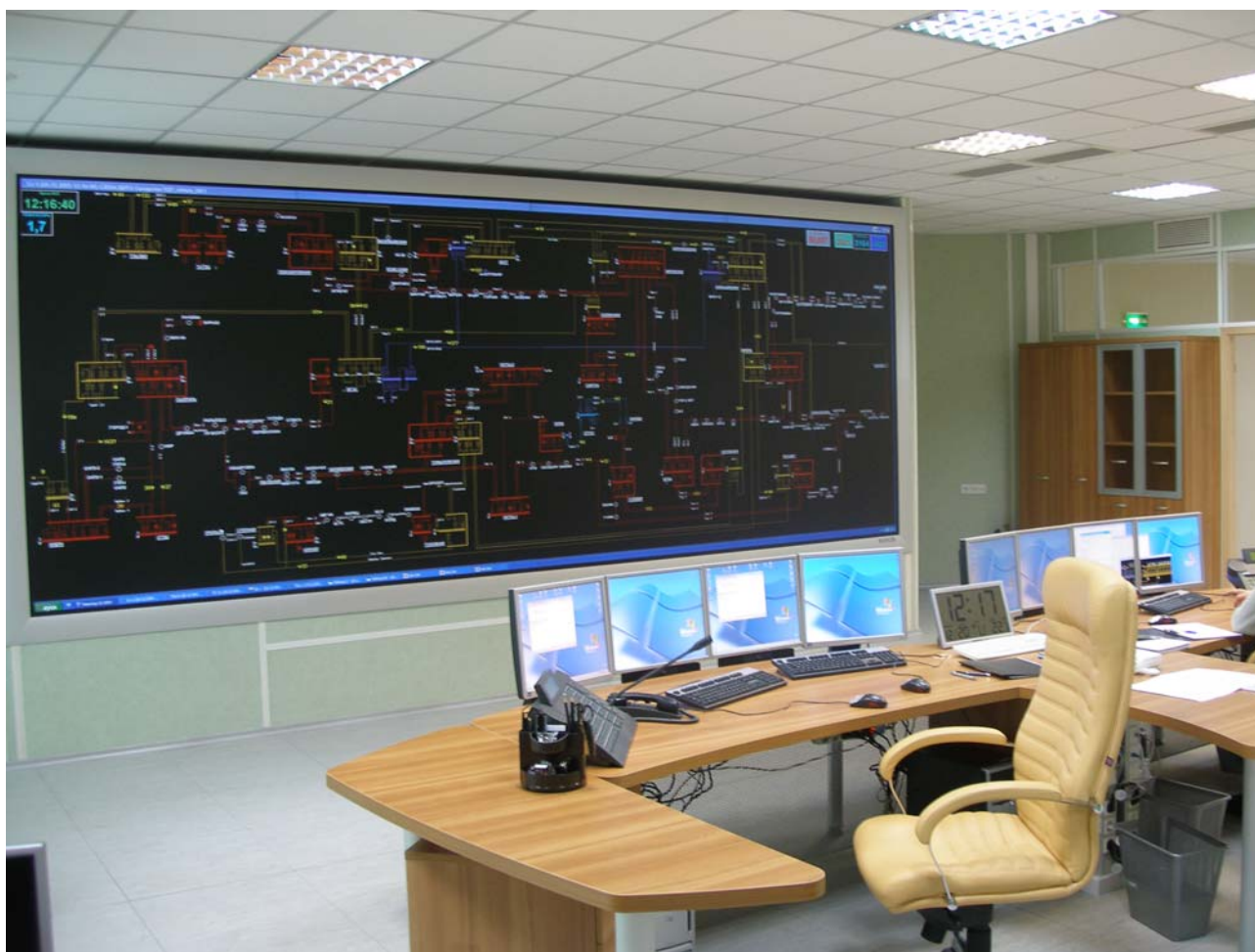
Видеопроекционный диспетчерский щит Самарского РДУ – филиала ОАО «СО – ЦДУ ЕЭС»
