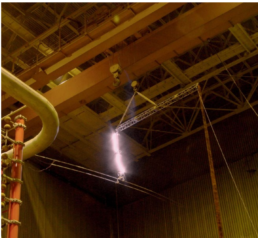
Испытания линейной изоляции на генераторе импульсного напряжения
