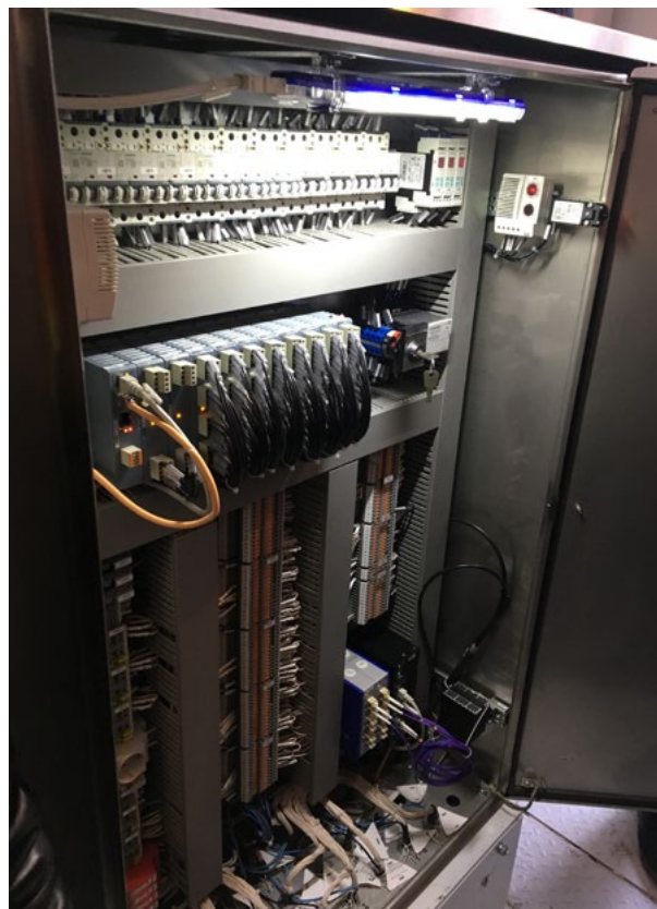
Контейнер наружной установки ячейки выключателя 500 кВ с DMU
