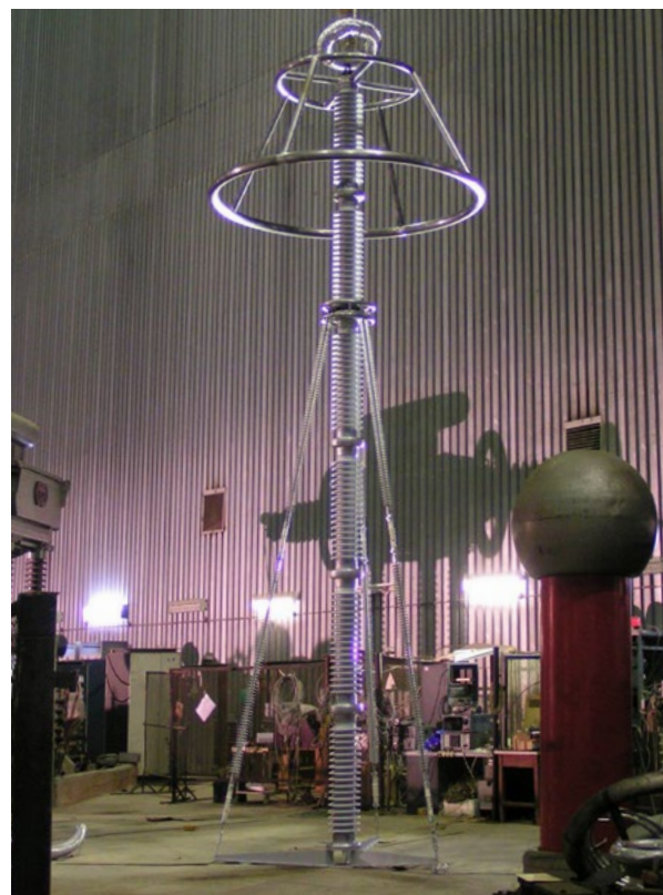
Испытания ограничителя перенапряжений 750 кВ
