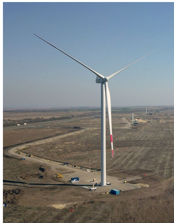
Строительство Сулинской ВЭС
