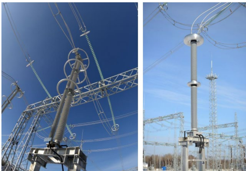
Цифровые трансформаторы тока (а) и трансформаторы напряжения (б) на ПС 500 кВ Тобол
