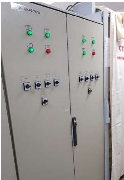
Шкаф связи УКПА на ПС Южная производства компании «Прософт-Системы», установленный в рамках проекта модернизации ЦСПА ОЭС Урала
