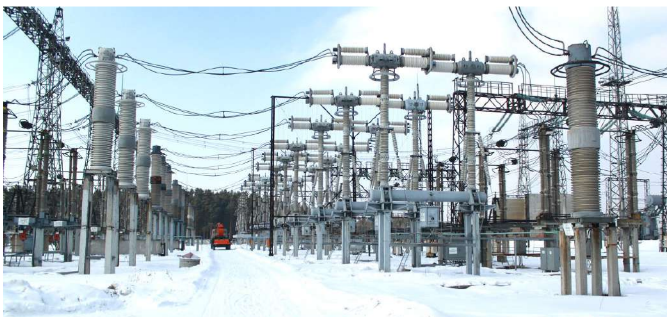
Подстанция 500 кВ Южная – важнейший узловой питающий центр ОЭС Урала
