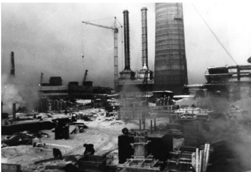
Строительство Пензенской ТЭЦ-1
