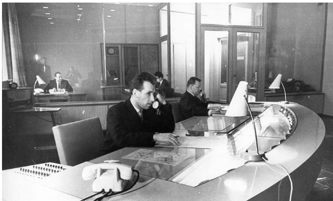
Диспетчерский зал ОДУ Северо-Запада в здании Латвэнерго, диспетчер Висвалдис Трейманис, 1966 год
