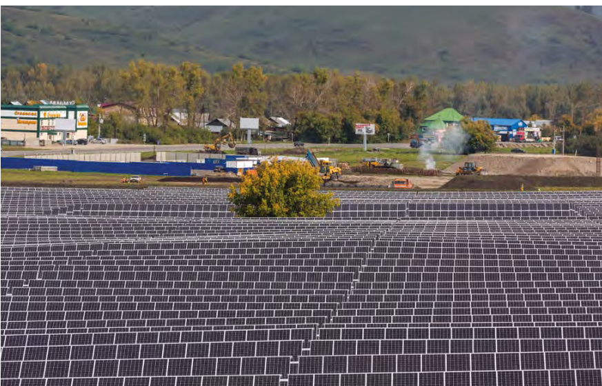
Майминская солнечная электростанция
