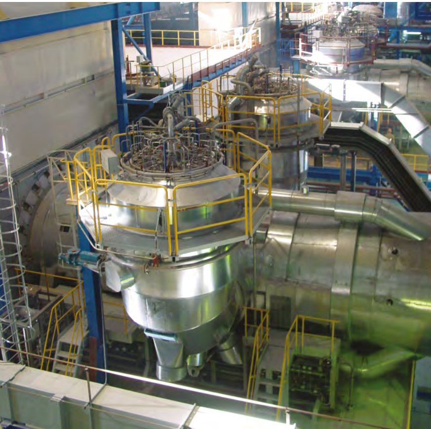
Газовые турбины SIEMENS Калининградской ТЭЦ-2
