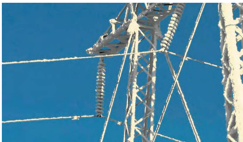
Гололед на проводах ЛЭП 110кВ
