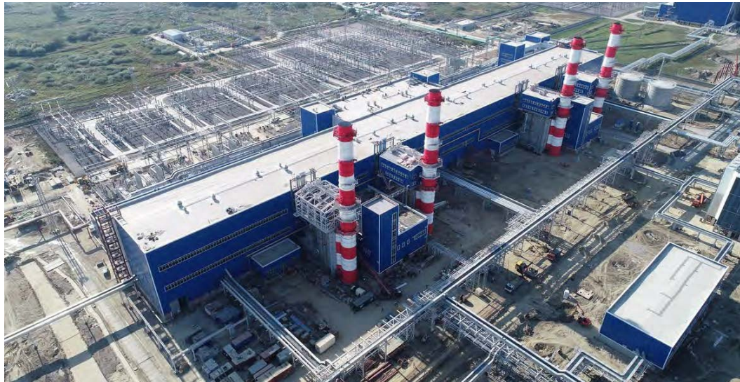
Прегольская ТЭС мощностью 454 МВт
