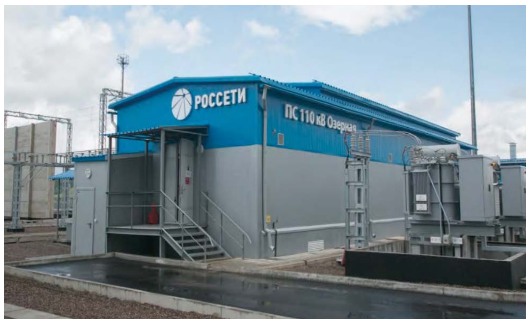
Новая подстанция 110 кВ Озерная
