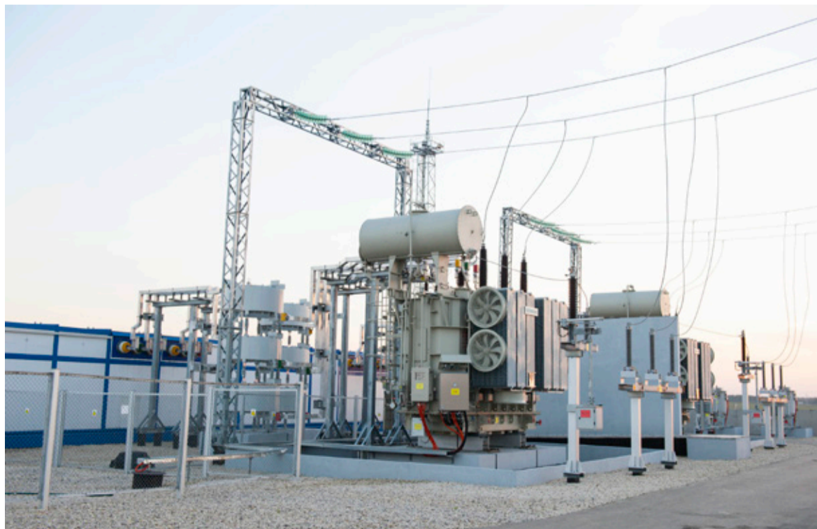
Для обеспечения энергоснабжения индустриального парка «Узловая» введена ПС 110 кВ Индустриальная
