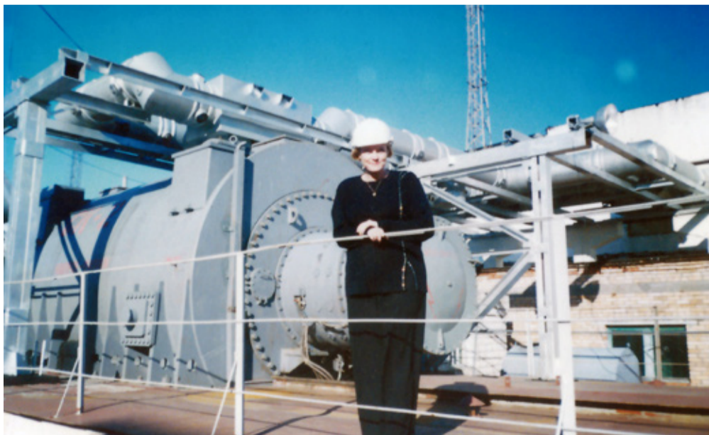
На подстанции 500 кВ Дальневосточная в поселке Сибирцево, 2001 год
