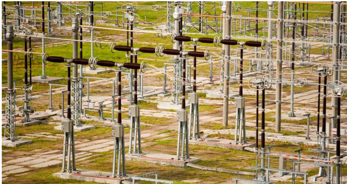
ПС 750 кВ Ленинградская – именно ее автоматика дает сигнал на отключение генераторов Ленинградской АЭС при коротких замыканиях на связях ОЭС Северо-Запада и ОЭС Центра
