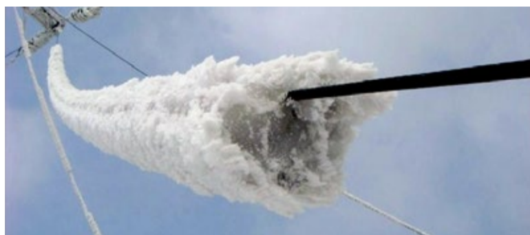
В 2016 году проведены работы по оснащению схемами плавки гололеда 11 линий электропередачи
