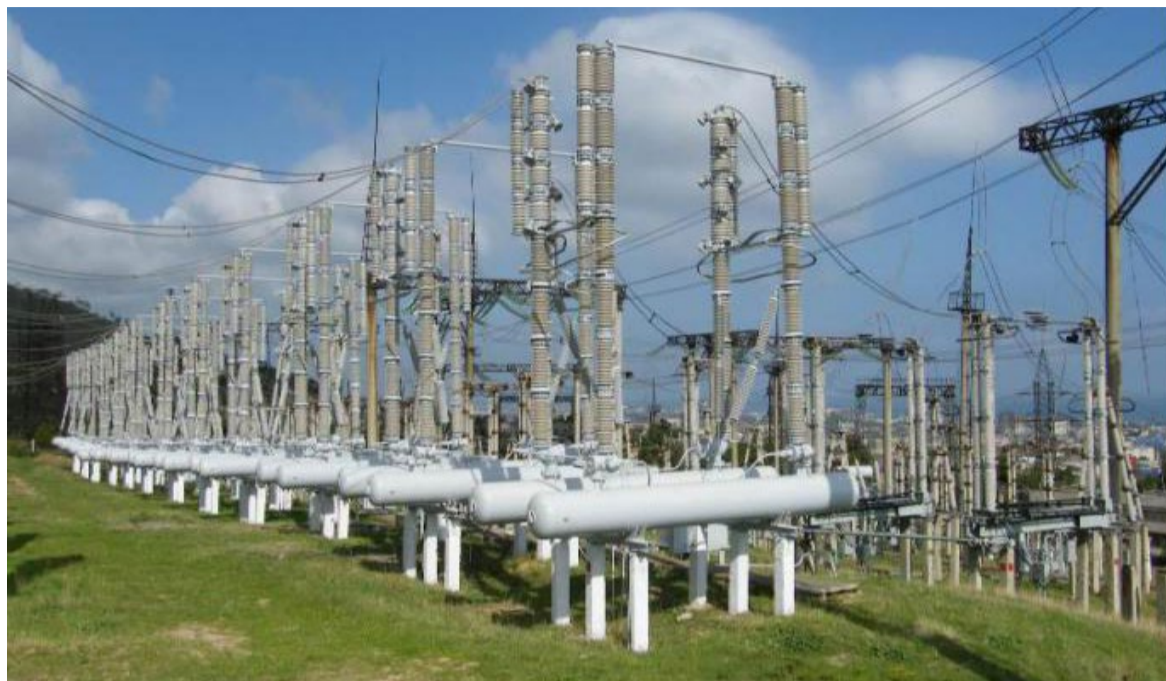
Подстанция 330 кВ Чирюрт – новое низовое устройство Централизованной системы противоаварийной автоматики ОЭС Юга
