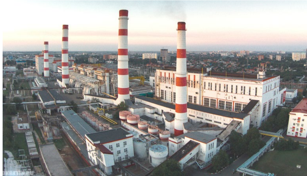
На Краснодарской ТЭЦ введена в промышленную эксплуатацию система мониторинга системных регуляторов
