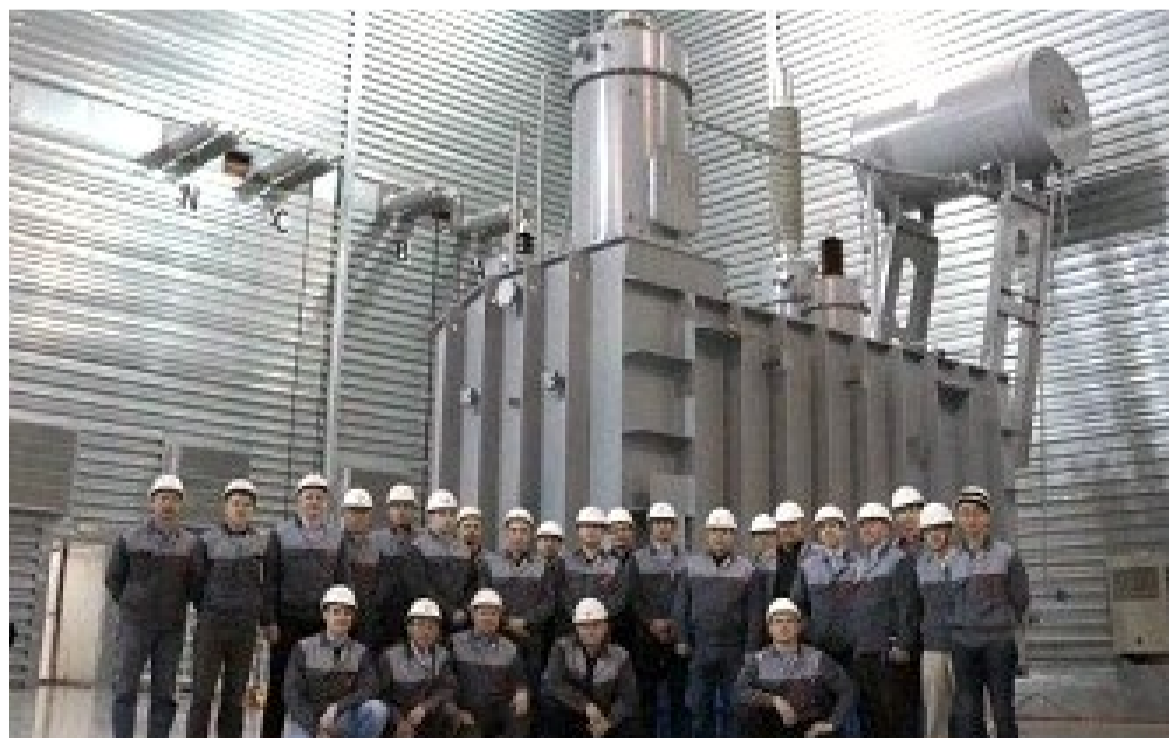
Автотрансформатор 500 кВ для модернизации подстанции Газовая в Оренбургской области
