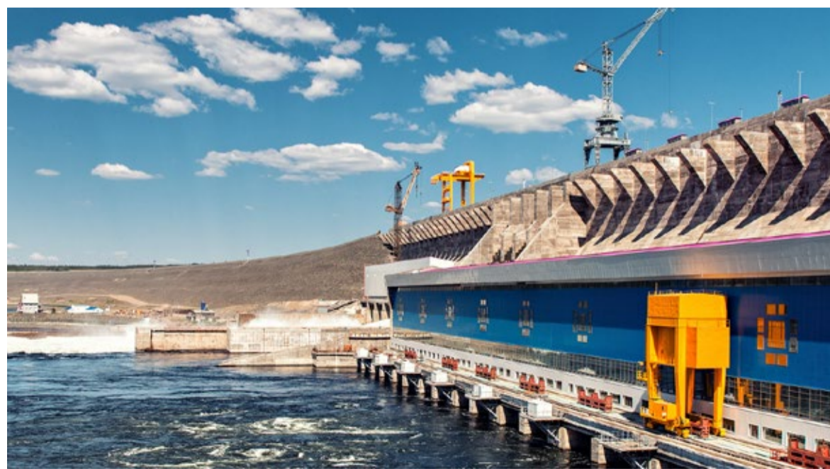
Ввод ГРАМ Богучанской ГЭС в промышленную эксплуатацию увеличивает возможности автоматического вторичного регулирования частоты и перетоков активной мощности в операционной зоне ОЭС Сибири
