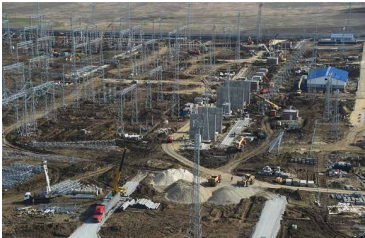
Строительство второй очереди энергомоста
