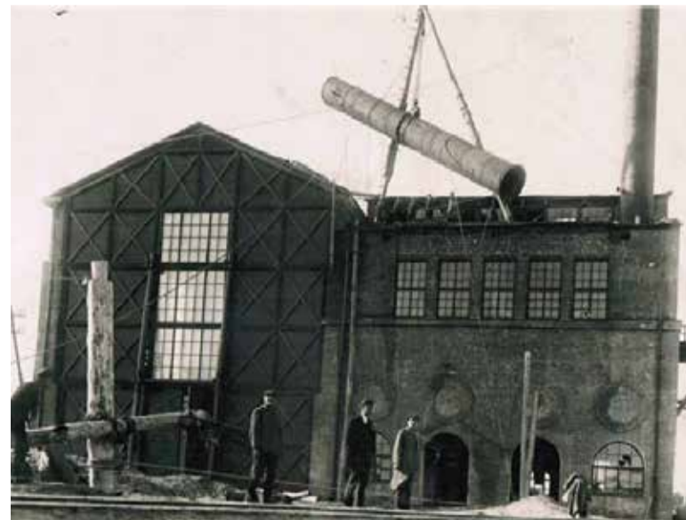
Южный фасад Ляпинской ГРЭС, монтаж дымовой трубы, 1920-е годы
