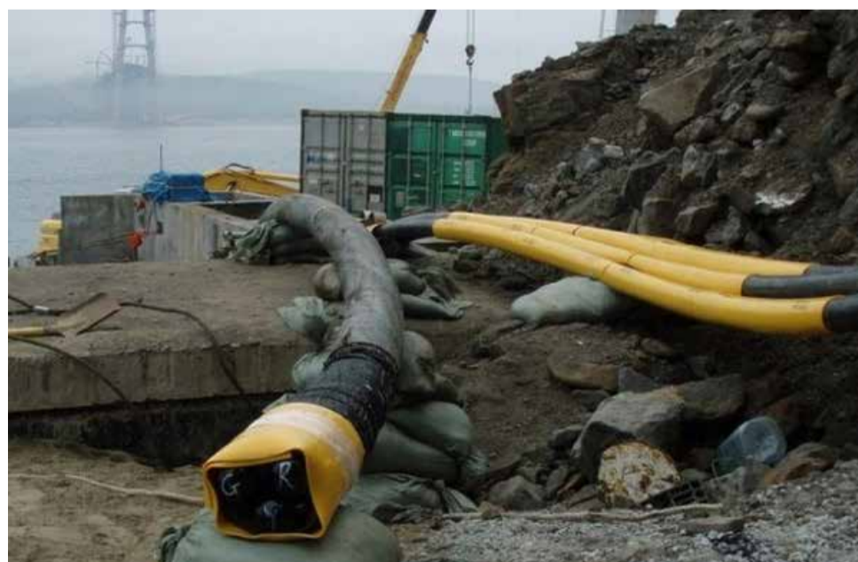
Ведется укладка подземного кабеля энергомота по дну Керченского пролива
