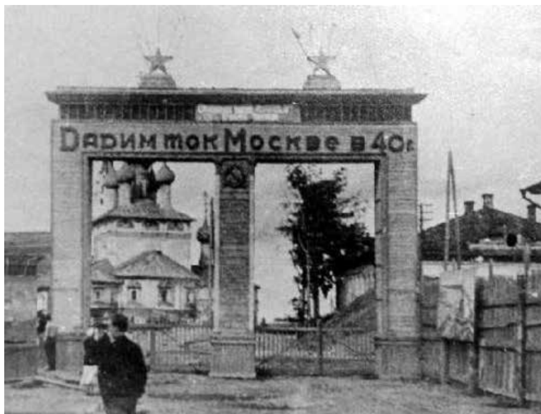
Триумфальная арка на строительстве Рыбинской ГЭС
