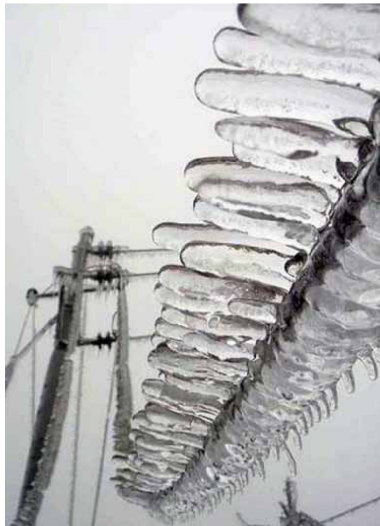
Гололед на воздушных линиях электропередачи
