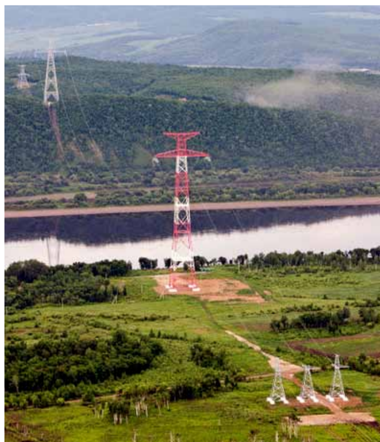
ВЛ 500 кВ Зейская ГЭС – Амурская
