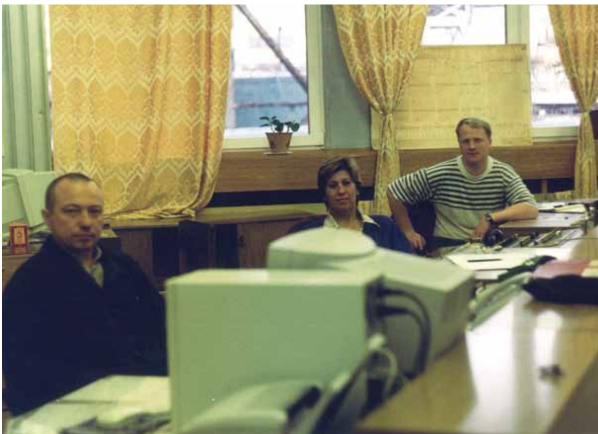
На главном щите управления Красноярской ТЭЦ-2, 2001 год
