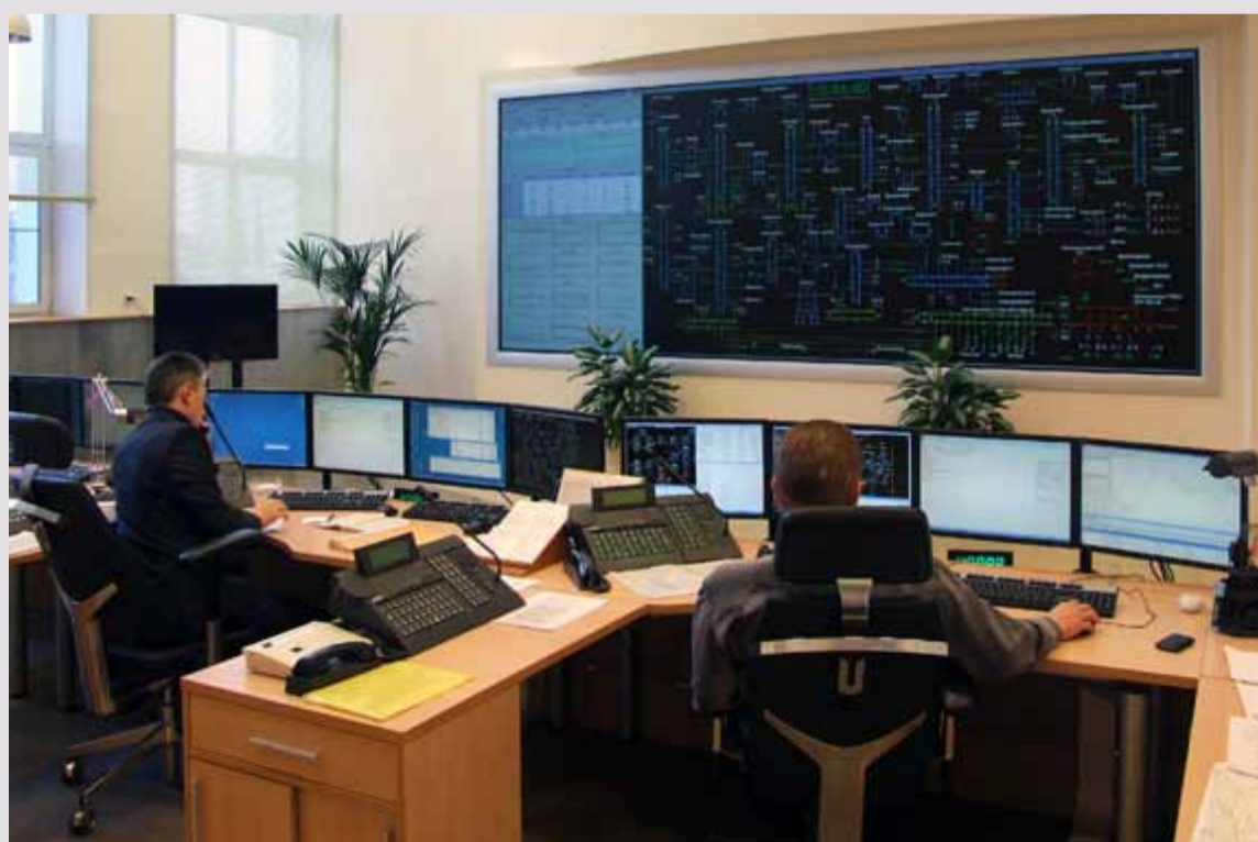
Из диспетчерского центра Костромского РДУ (на фото) будет осуществляться оперативно-диспетчерское управление энергосистемой Ивановской области
