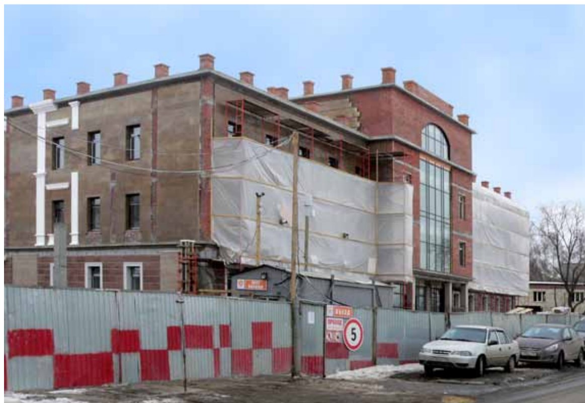
Строительство здания РДУ Татарстана перешло в завершающую фазу
