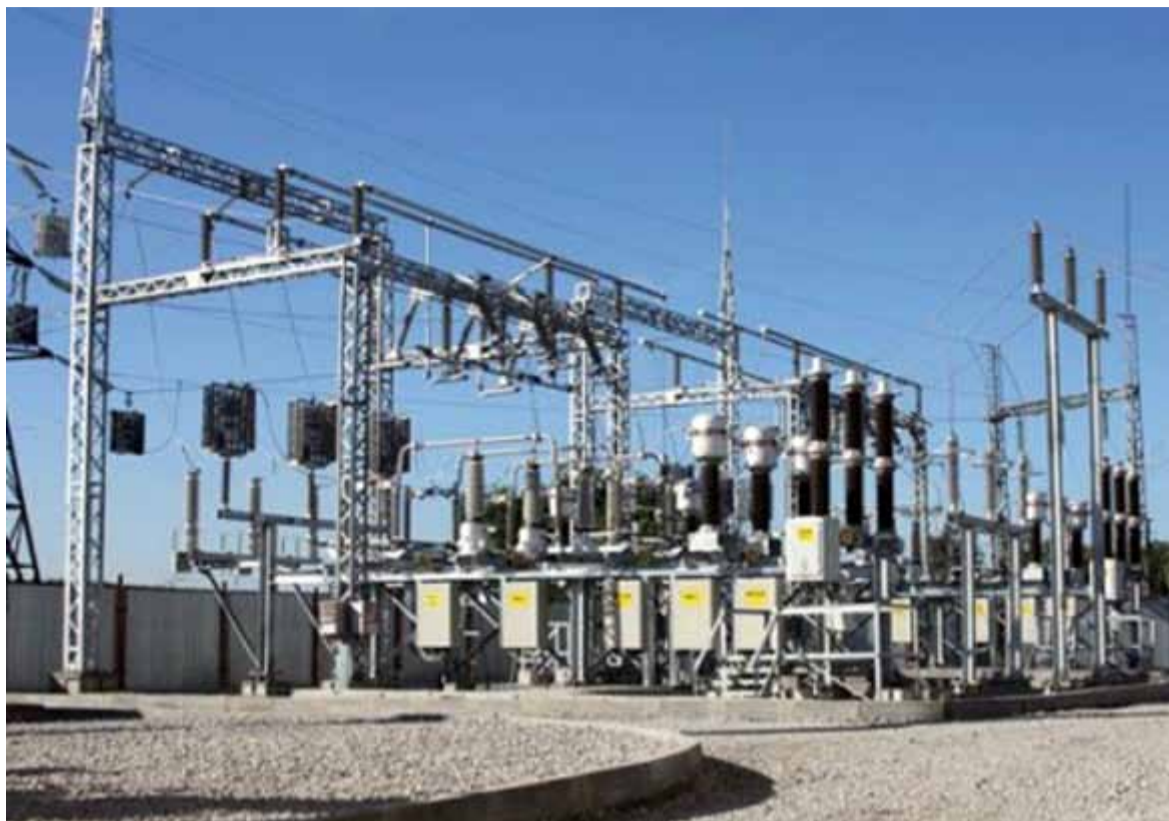
Подстанция 500 кВ Киндери
