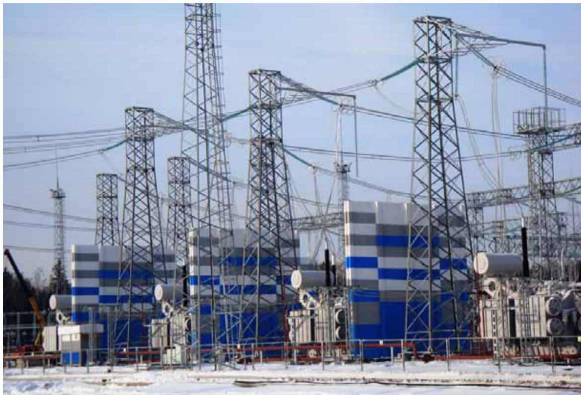
ПС 750 кВ Грибово
