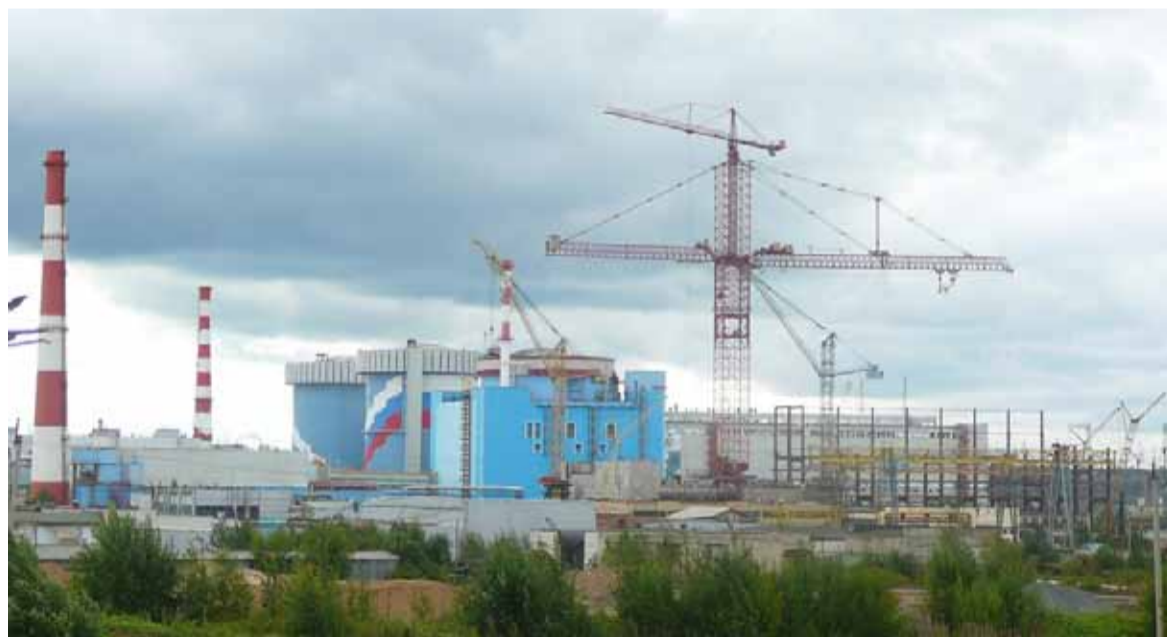
Строительство энергоблока на Калининской АЭС
