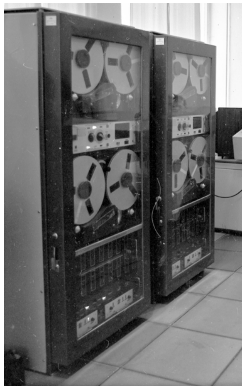
Магнитофоны для записи диспетчерских переговоров. ОДУ Урала, 80-е годы XX века
