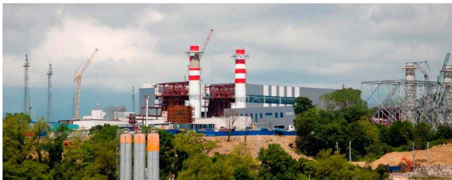
Системный оператор обеспечил режимное сопровождение испытания и ввода в работу Адлерской ТЭС
