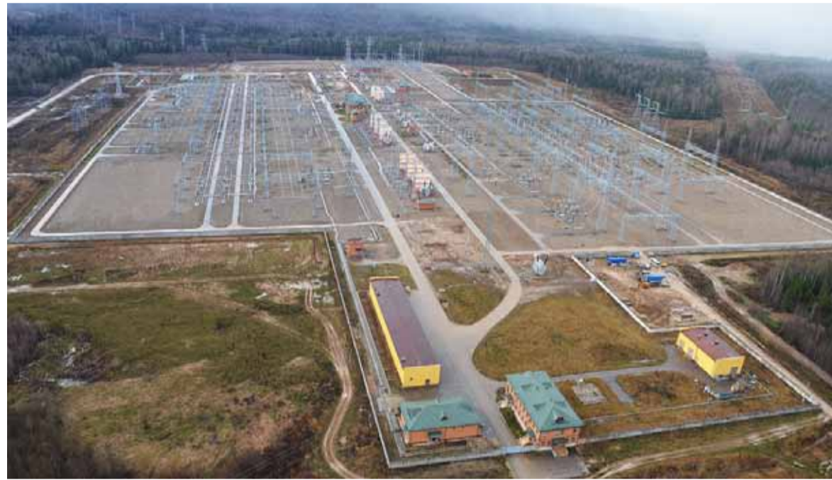
ПС 750 кВ Грибово
