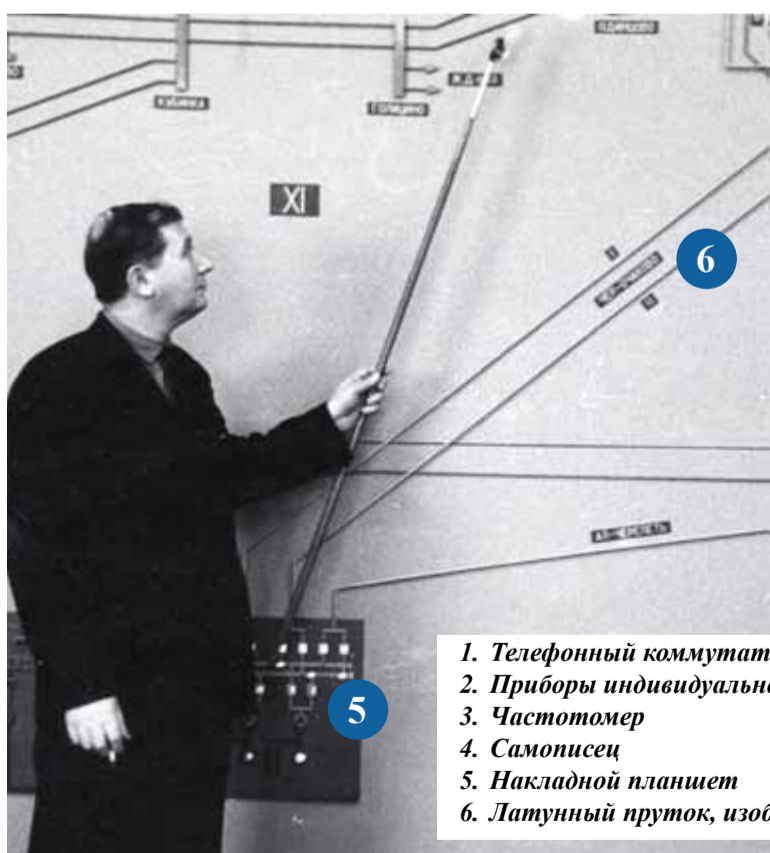
Диспетчерский центр Мосэнерго, 60-е годы XX века. Размещение сигнальных значков на щите
