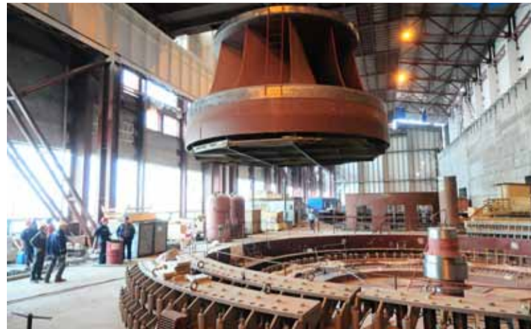
Монтаж ГА-8 Богучанской ГЭС
