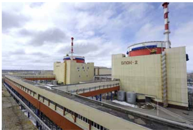
Новые энергоблоки Ростовской АЭС
