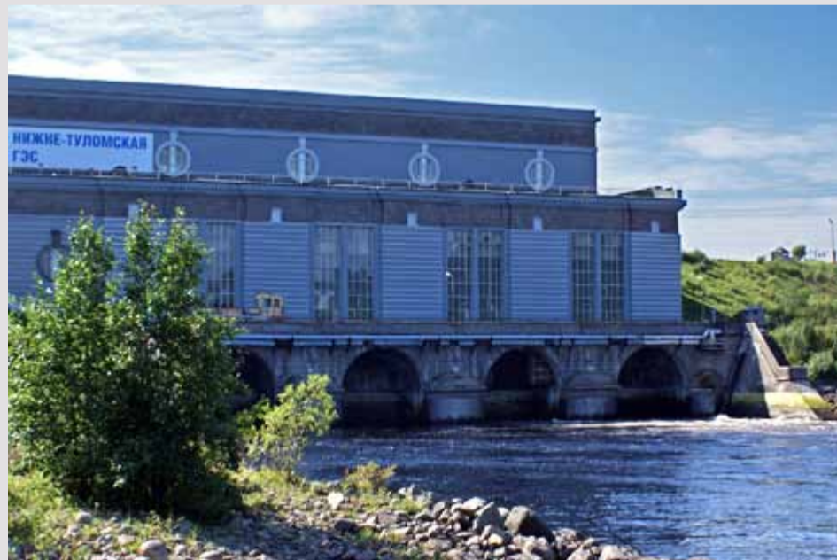
Нижнетуломская ГЭС – одна из 17-ти малых и средних ГЭС. Установленная мощность 57,2 МВт. Введена в эксплуатацию в 1937 году, когда архитекторы промышленных зданий еще не стеснялись их украшать. Поэтому в ее внешнем виде есть своя эстетика и индивидуальность.
