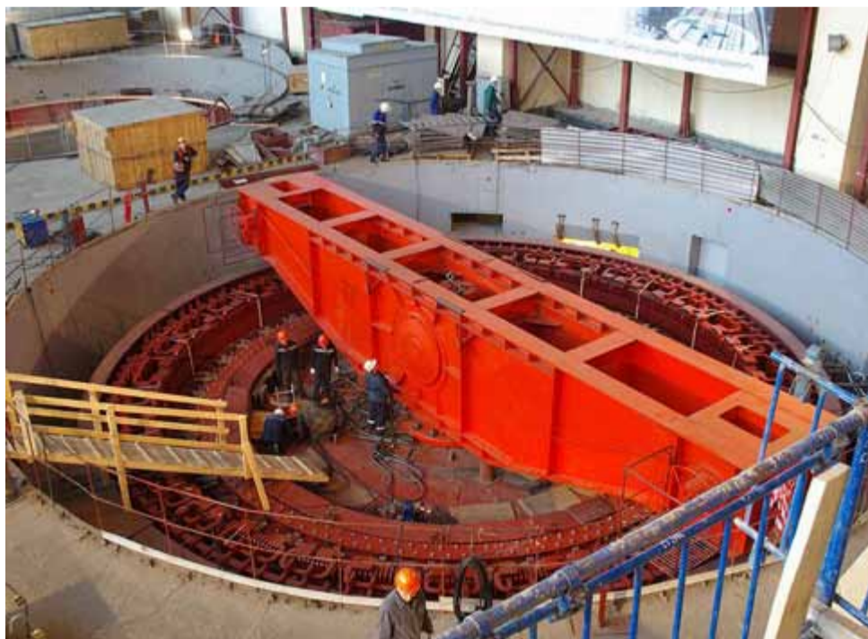
Октябрь 2011 года. Установка ротора гидроагрегата № 1
