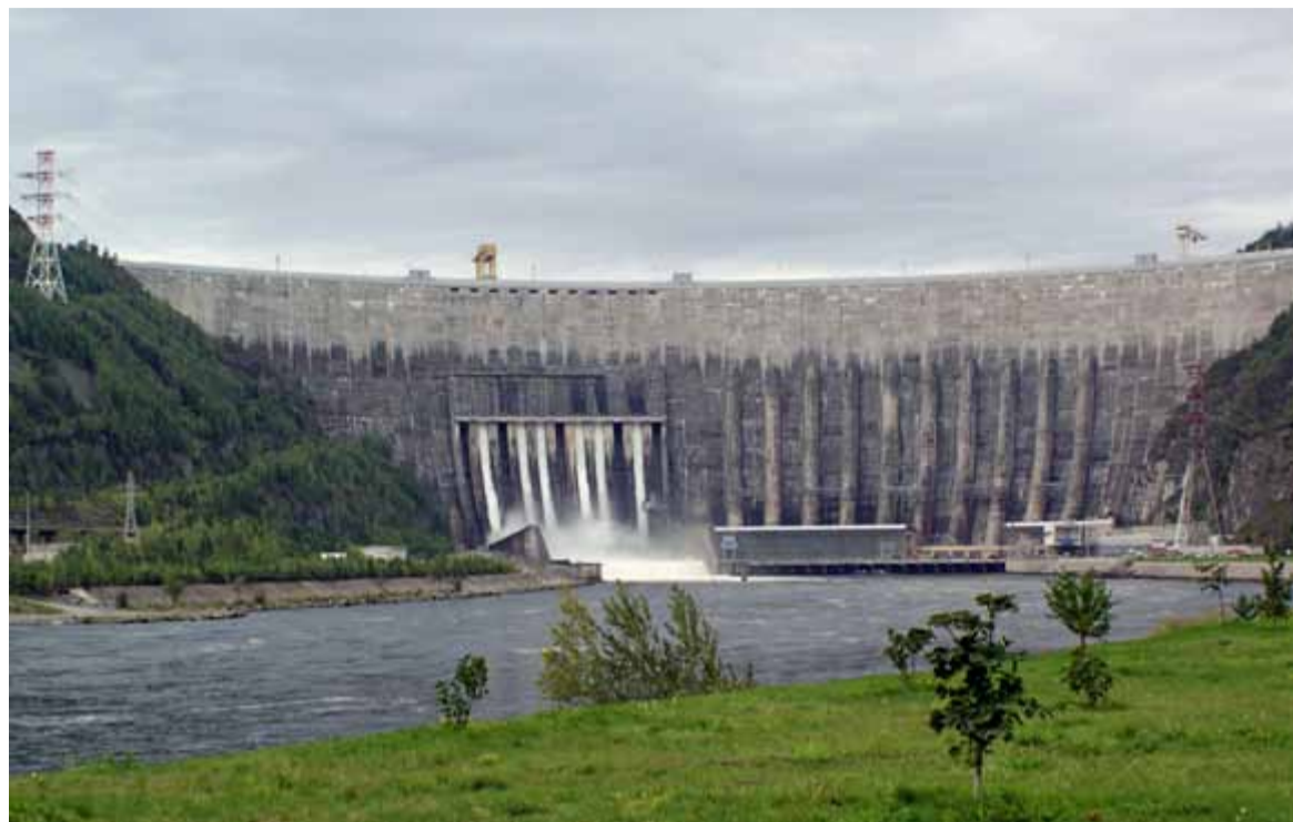
Саяно-Шушенская ГЭС им. П.С. Непорожного
