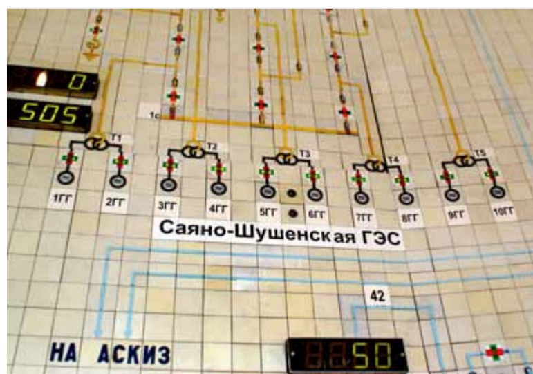
Саяно-Шушенская ГЭС на диспетчерском щите Хакасского РДУ
