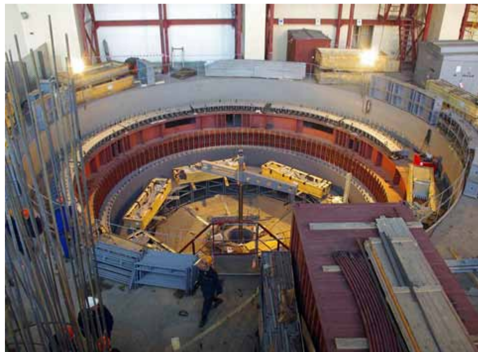
Октябрь 2011 года. Работы по восстановлению гидроагрегата № 2
