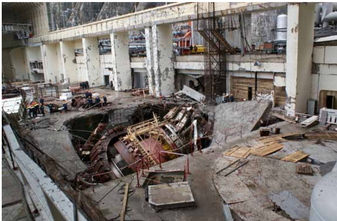
Разрушенный гидроагрегат № 2
