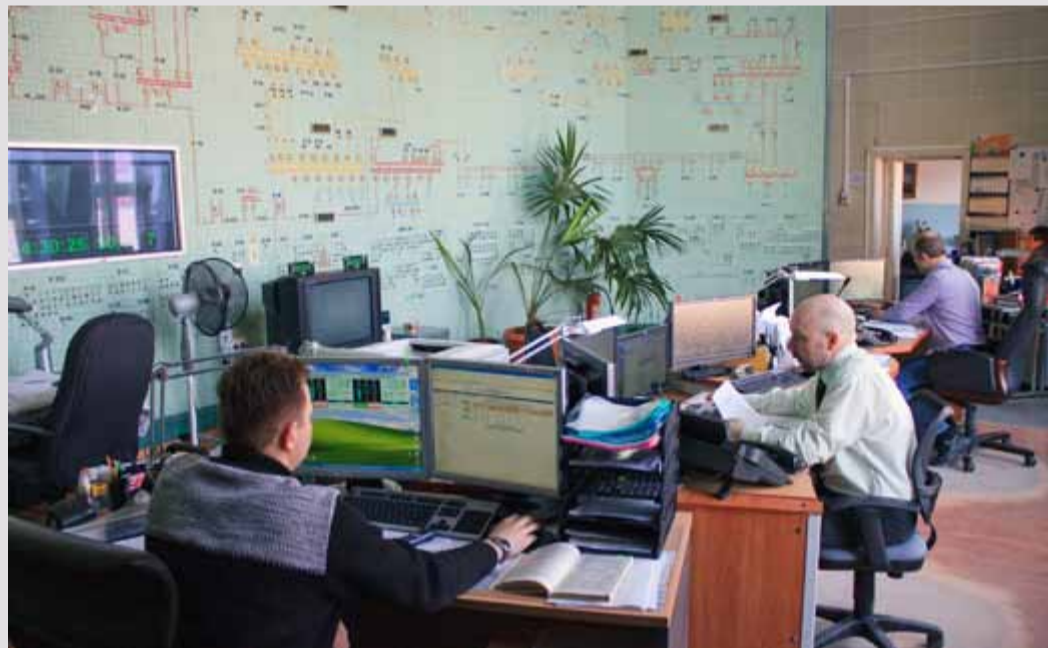
Диспетчерский центр Кольской энергосистемы
