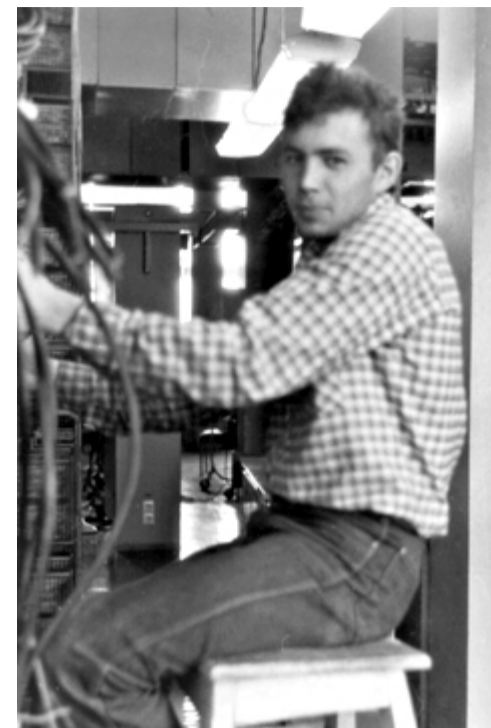
На телефонной станции
