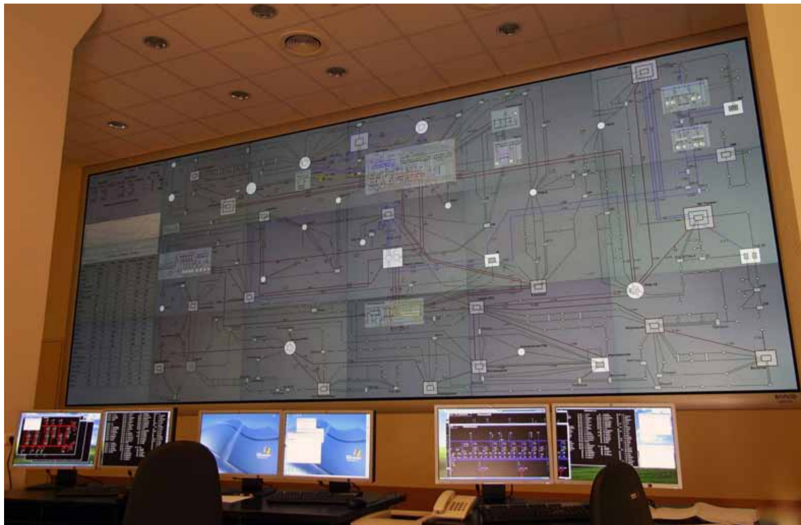
Современный диспетчерский пункт Ленинградского РДУ
