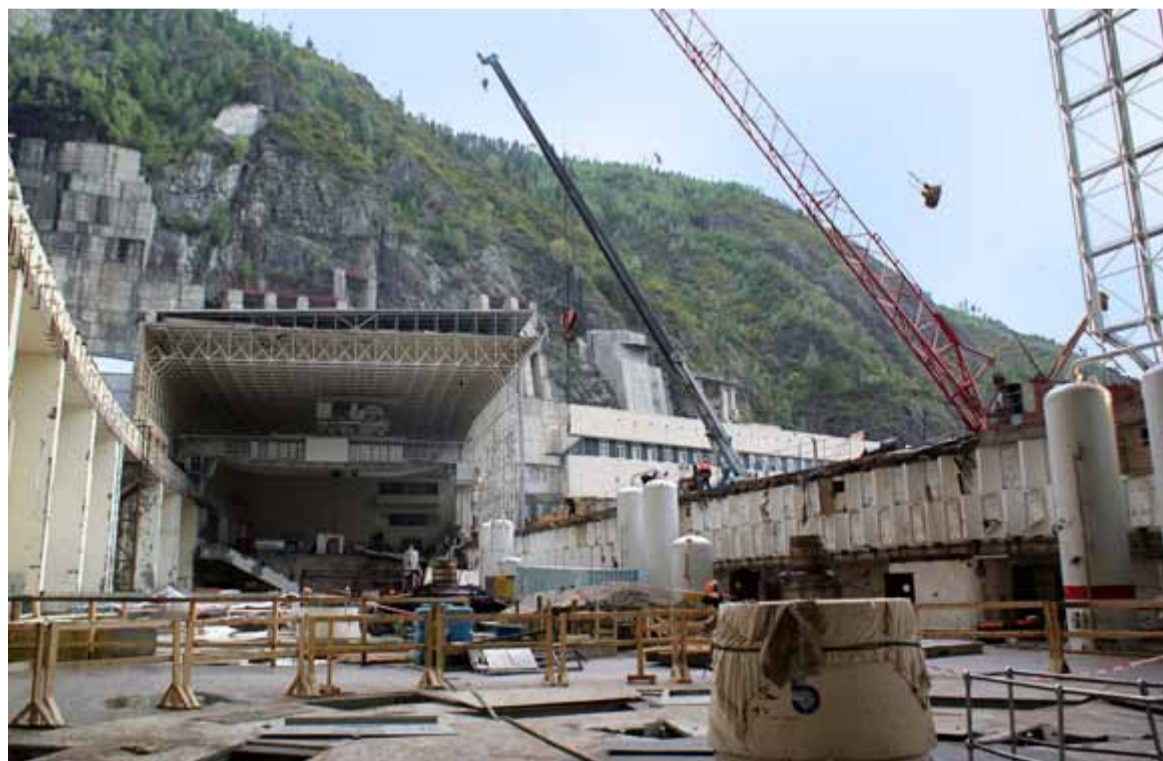
Разрушенная крыша машинного зала
