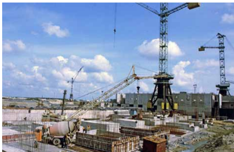
Строительство Балтийской АЭС
