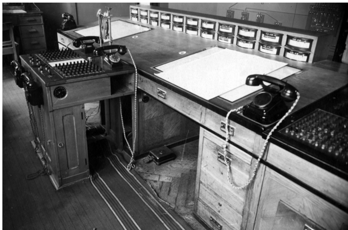
Первый диспетчерский пульт с приборами отображения электрических параметров
