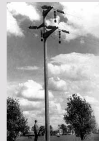
Линии электропередачи 60 кВ
