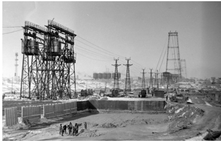
Строительство Сталинградской ГЭС, 1956 год
