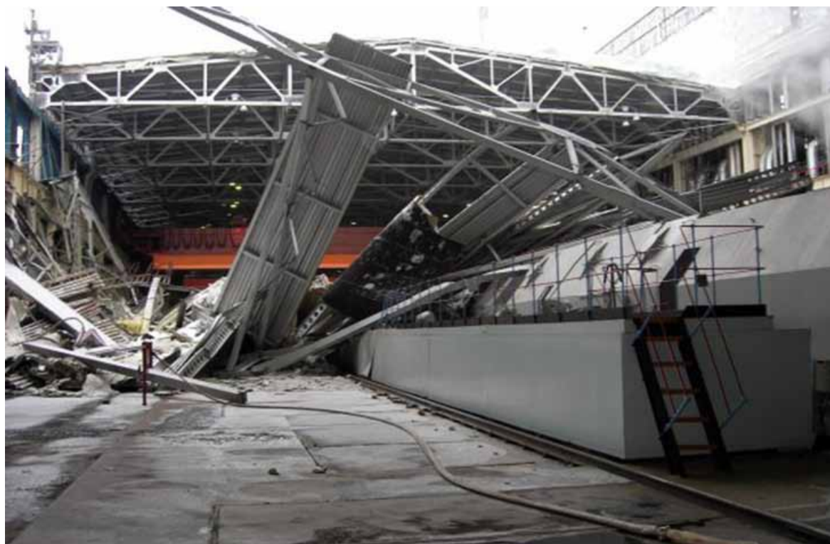
Разрушенная кровля машинного зала
