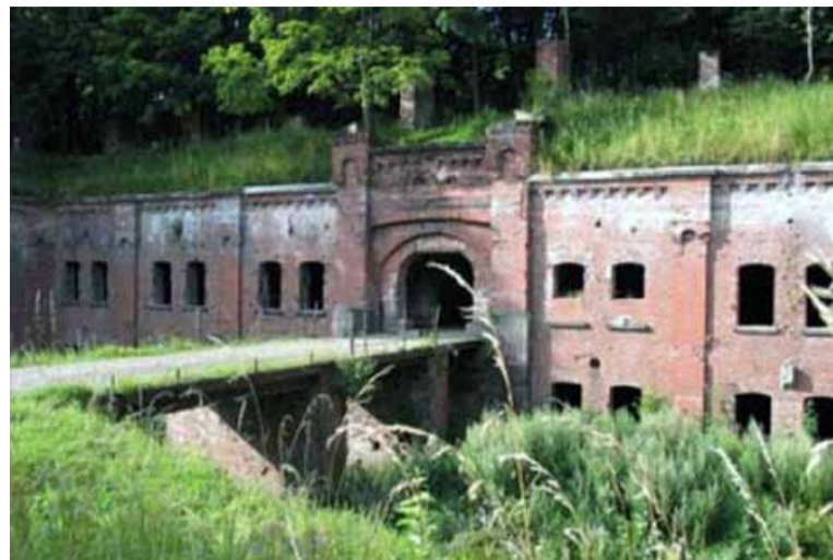
Один из полуразрушенных фортов Калининграда
