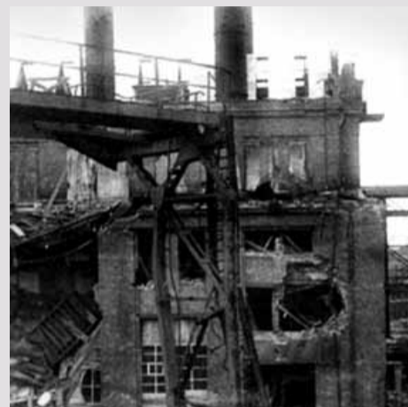
Разрушенная ГРЭС-1, 1945 год
