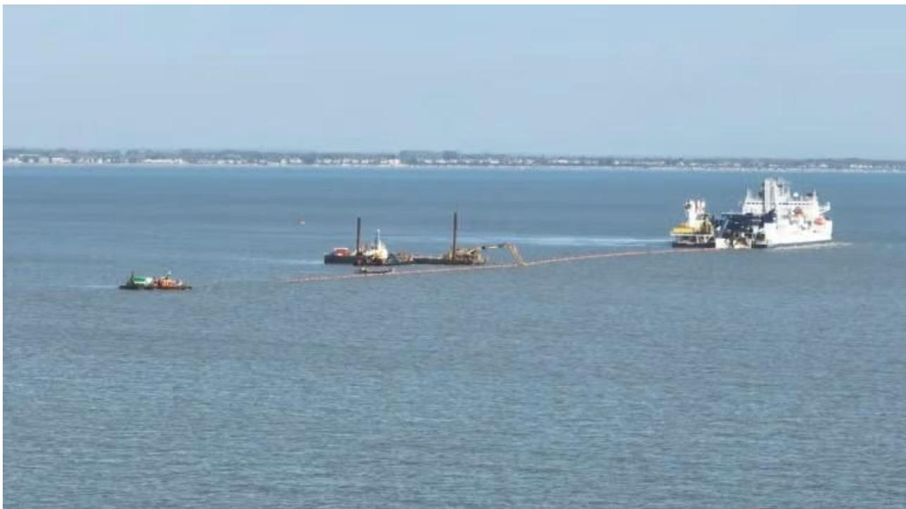
Трансграничное HVDC соединение NeuConnect напряжением 525 кВ, пропускной способностью 1,4 ГВт и протяженностью 725 км – первая прямая электрическая связь между энергосистемами Великобритании и Германии. NeuConnect будет проложено через территориальные воды Великобритании, Нидерландов и Германии и свяжет ППС на о. Грэйв в графстве Кент (Юго-Восточная Англия) и ППС в Вильгельмсхафене, на севере Германии.
