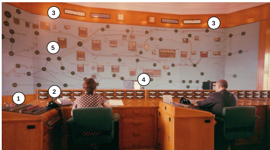
Диспетчерский щит ОДУ ЕЭС с накладными планшетами, 1960-е годы.
