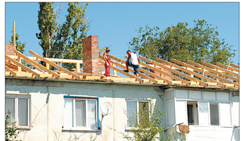
Новые двускатные металлические кровли прослужат в шесть раз дольше, чем старые рубероидные
