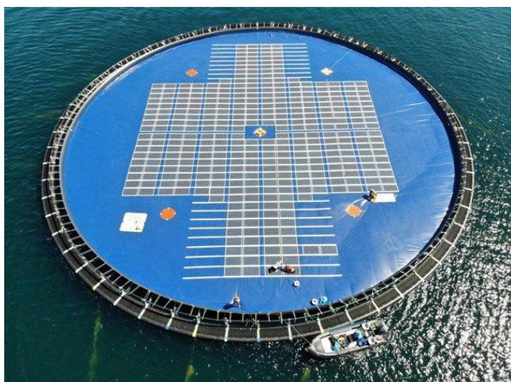
Суммарная мощность солнечных панелей, размещенных на каждой из четырех платформ, входящих в состав СЭС на водохранилище Vanja, составит 0,5 МВт. В настоящее время Ocean Sun предлагает 2 варианта плавучих платформ с фотоэлектрическими панелями: на 0,5 МВт и 0,2 МВт.
