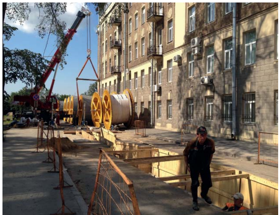
Прокладка КЛ 330 Василеостровская — Завод Ильича
