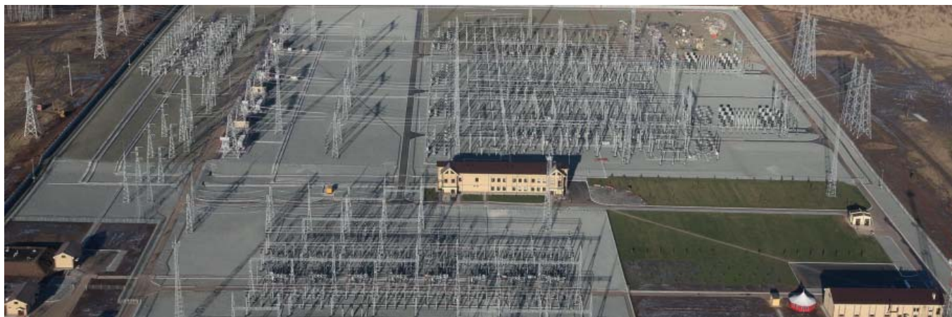
ПС 500 кВ «Щелоков» (г. Елабуга)
