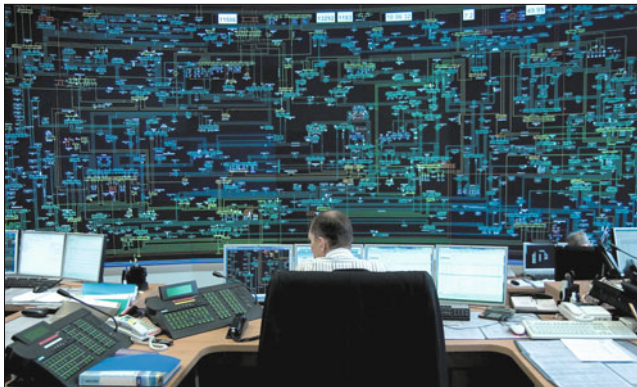
Новый диспетчерский щит в Московском РДУ
