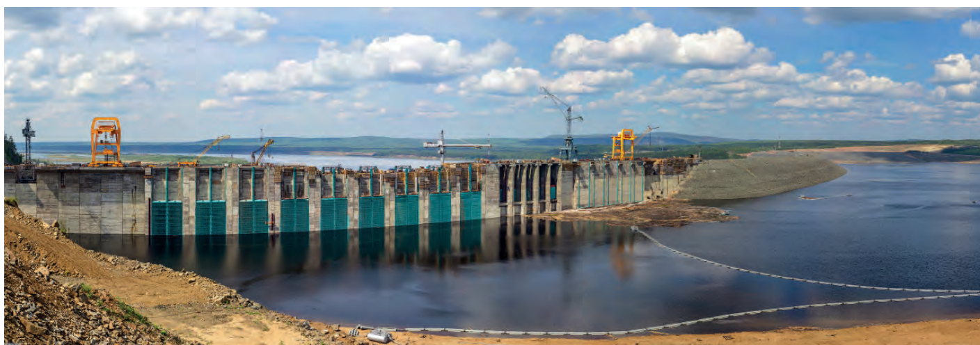
Богучанская ГЭС, заполнение водохранилища
