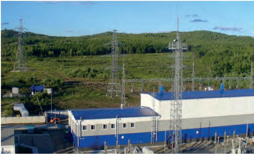
Подстанция 220 кВ Могоча
