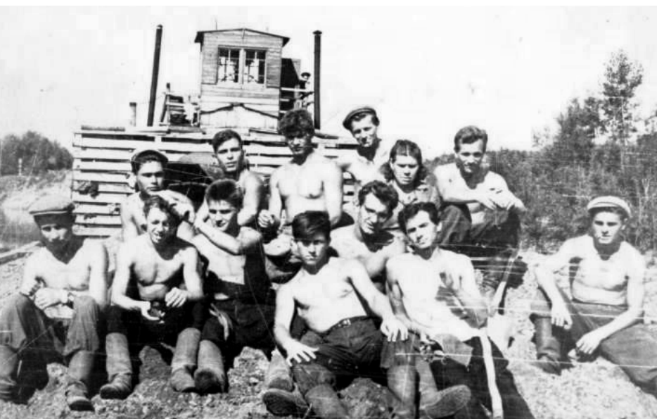
Стройотрядовцы Томского политехнического института. Разгрузка баржи на строительстве межколхозной Иксинской ГЭС. Леонтий Корягин первый слева, 1959 год
