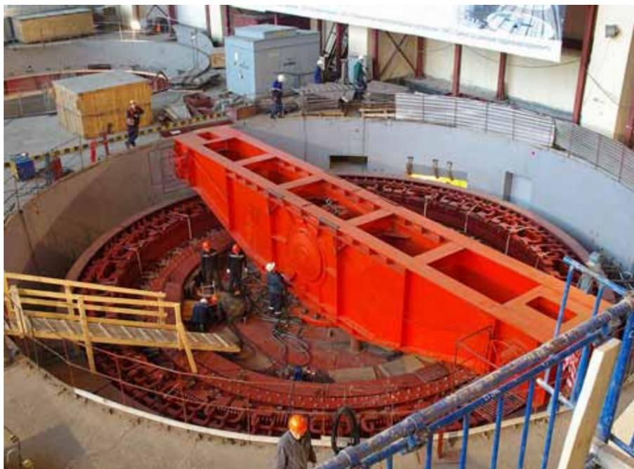
Октябрь 2011 года. Установка ротора гидроагрегата № 1
