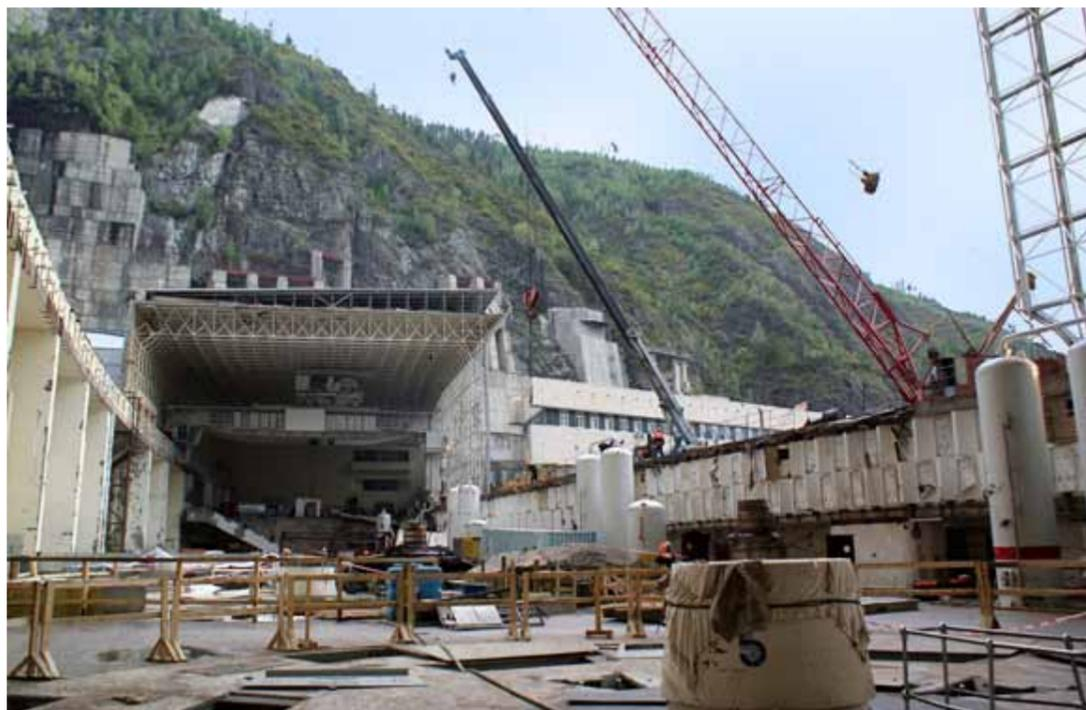
Разрушенная крыша машинного зала
