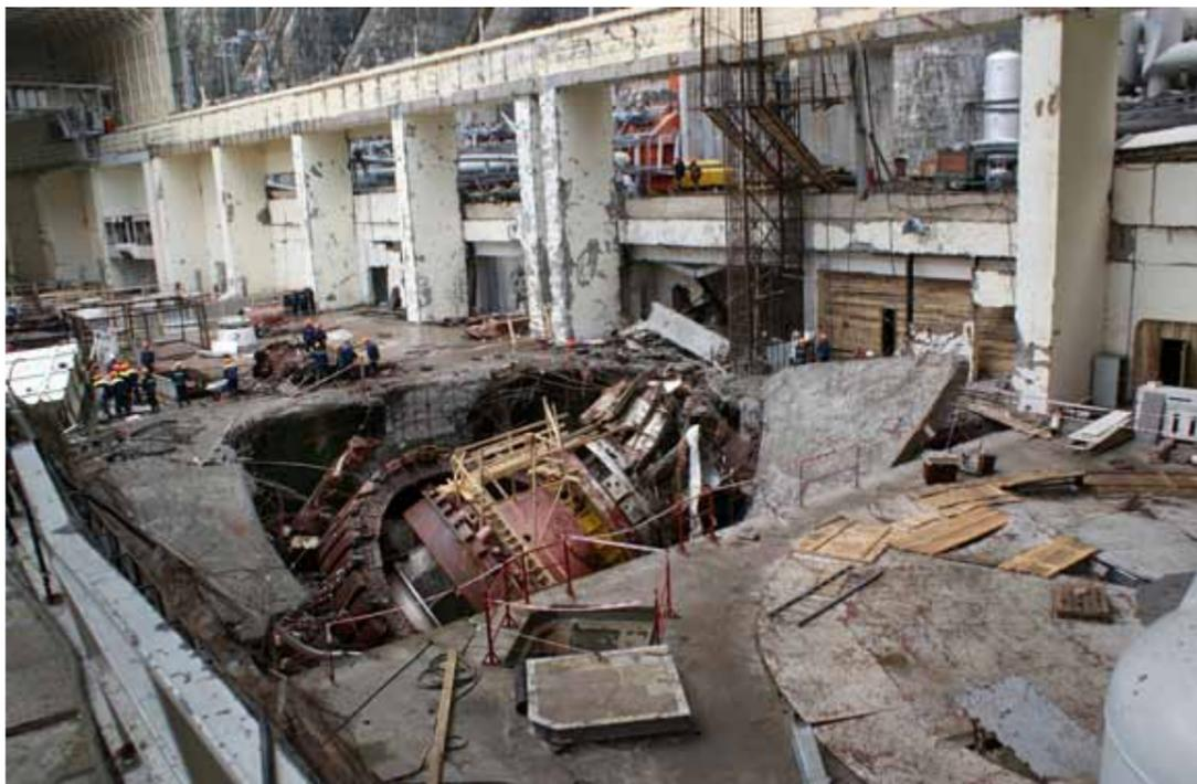
Разрушенный гидроагрегат № 2
